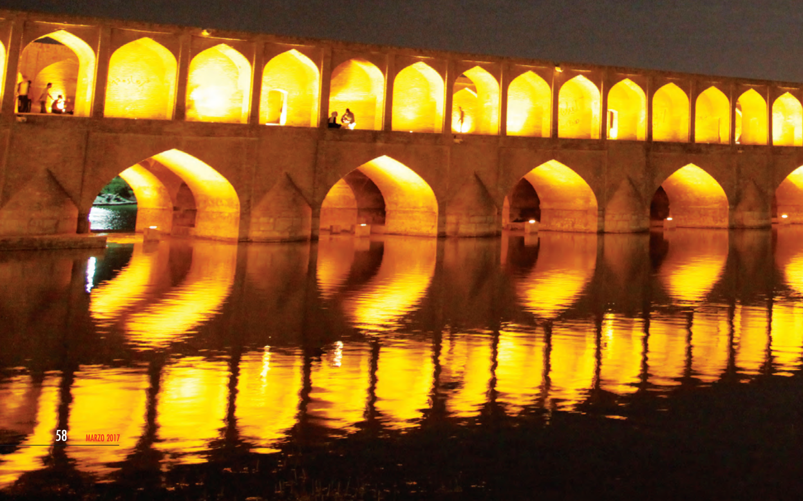
Isfahan, le 33 arcate del Ponte Si-o-seh del XVI secolo, lungo 298 metri
